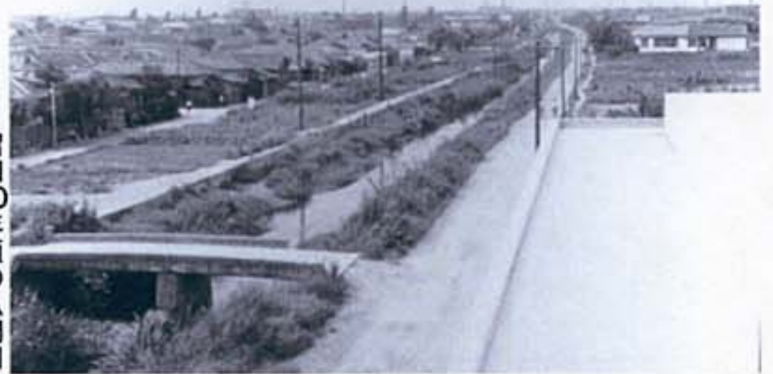
※写真提供：倉敷市史跡歴史資料整備室
