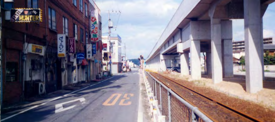
高架工事中の水島東常盤町(1992年10月25日) 安藤弘志氏撮影(倉敷市歴史資料整備室蔵)
